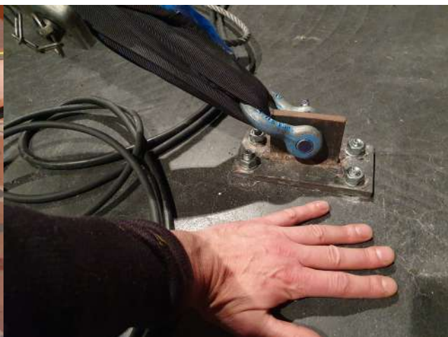
Point d'accroche au sol dans une dalle réalisé par nos soins
